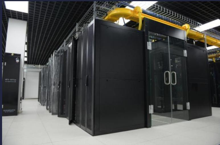
数据中心服务器机柜采用模块化机柜，分区域布局，机柜之间封闭冷通道精确制冷。机房墙体及外窗进行了封堵，墙壁加装了防火保温层（酚醛板）进行隔离，可有效防止冷量散失。
